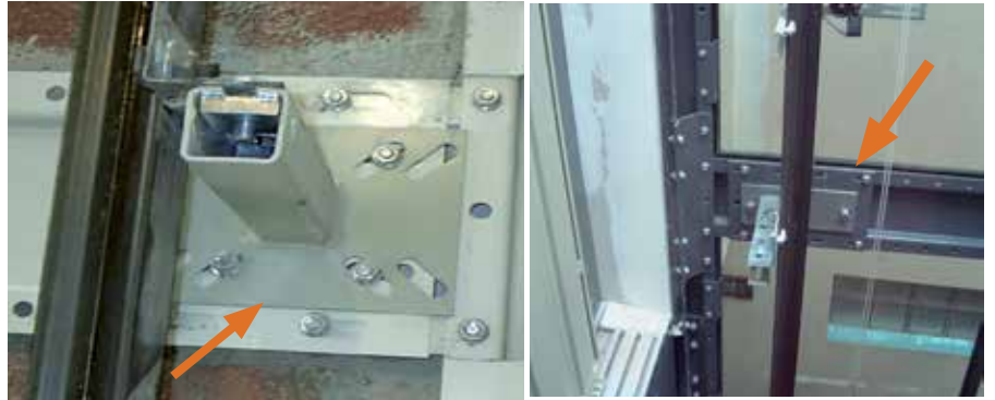
Abb. 3 a/b: Beispiele von Befestigungsplatten für die Schienenhalterungen der Aufzugshersteller
