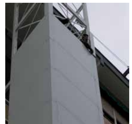
Abb. 4d: Schachtverkleidung mit Sandwichpaneelen
