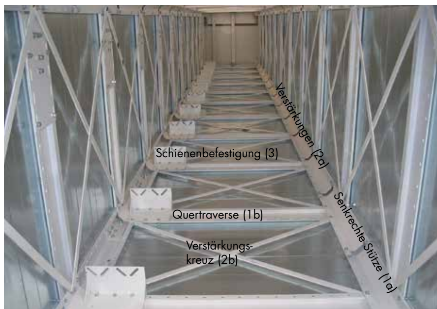
Abb. 2: Komponenten des DICTATOR Liftschachtsystems
