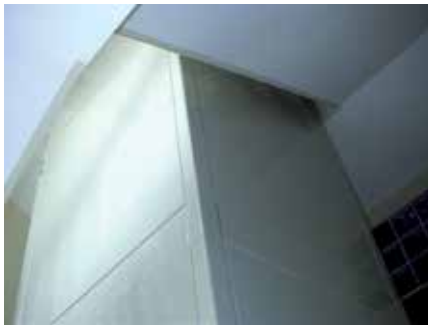
Fig. 4a: Estructura con cerramientos de chapa lisa...
