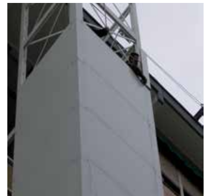
Fig. 4d: Estructura con cerramiento de paneles sandwich
