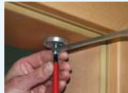
5. Tandheugelhouder aan het kozijn bevestigen.
