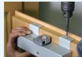
2. Deuraandrijving vastschroeven.
