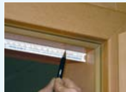
3. Boorgaten voor de tandheugelhouder op het kozijn aanbrengen.
