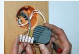
6. Netdeel aansluiten en in inbouw- resp. opbouwdoos plaatsen.
