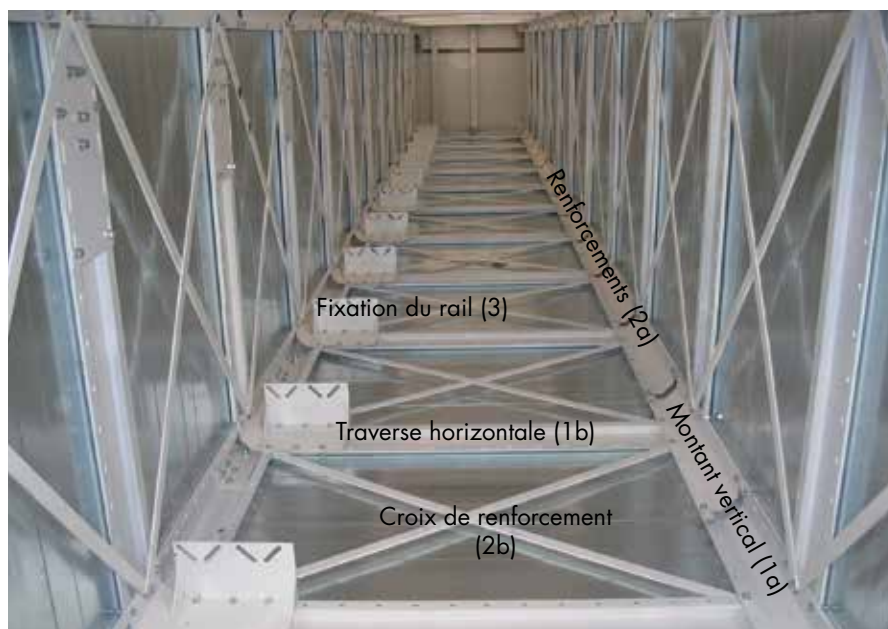
Ill. 2 : Éléments du système de gaine dictator
