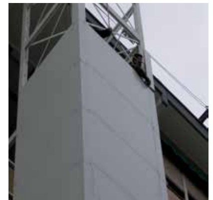
Ill. 4d : Revêtement de la gaine aux panneaux sandwich
